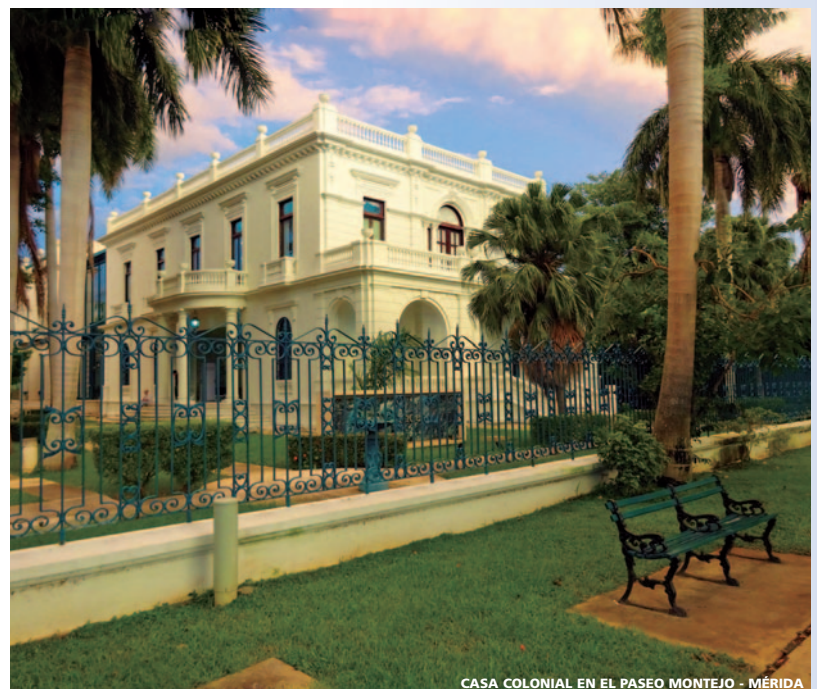
CASA COLONIAL EN EL PASEO MONTEJO - MÉRIDA
